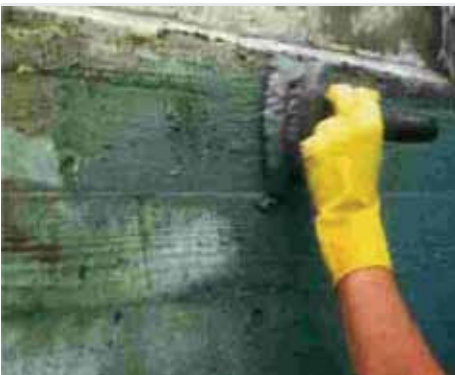
Fırça izleri, kaba tahta kalıp dokusu korunur.
