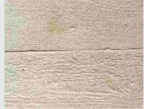
Sünger, sert kauçuk, mala veya kaba tahta kalıp ile oluşturulan doku korunur.
