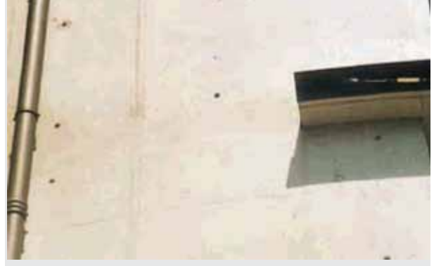
Büyük ölçüde ya da tamamen mineral renk eşleşme yoluyla düzeltilen yüzeyler
