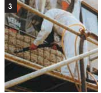
IBIX Kumlama Sistemleriyle* çelik takviyenin temizlenmesi. Pas giderme derecesi, DIN EN12944-4 uyarınca Sa 2,5
