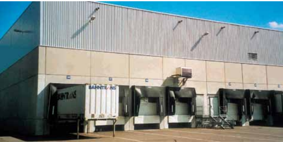
KEIM Concretal-lasur ile mineral tedavinin tamamlanmasından sonra homojen dengeli görünüm.
