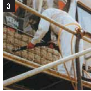
3 IBIX Kumlama Sistemleriyle* çelik takviyenin temizlenmesi. Pas giderme derecesi, DIN EN12944-4 uyarınca Sa 2,5
