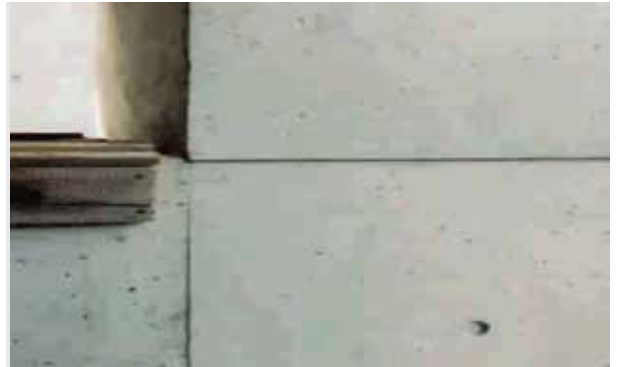
KEIM Concretal-Feinspachtel ile segregasyonlu alanların onarımı ve mineral renk eşleşme yoluyla düzeltilen yüzeyler
