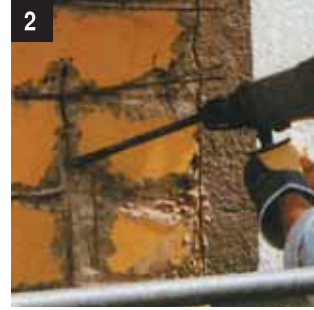
Paslanmış çelik donatının açığa çıkması
